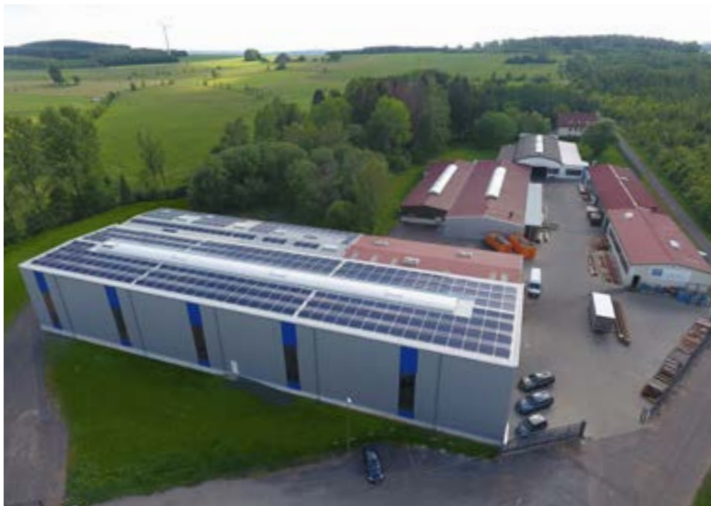
Die neue Produktionshalle (vorne) eröffnet neue Produktionskapazitäten.
